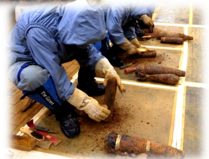
砲弾整備作業 (土、錆を除去)
