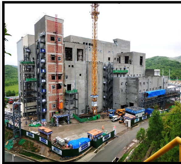
危険廃棄物処理設備棟
