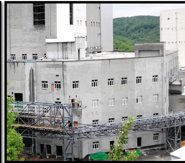
大型廃棄処理設備運転棟
