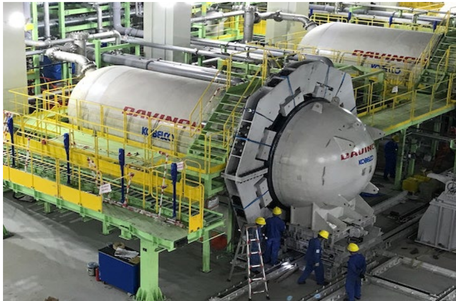
大型廃棄処理設備【株神戸製鋼所】
