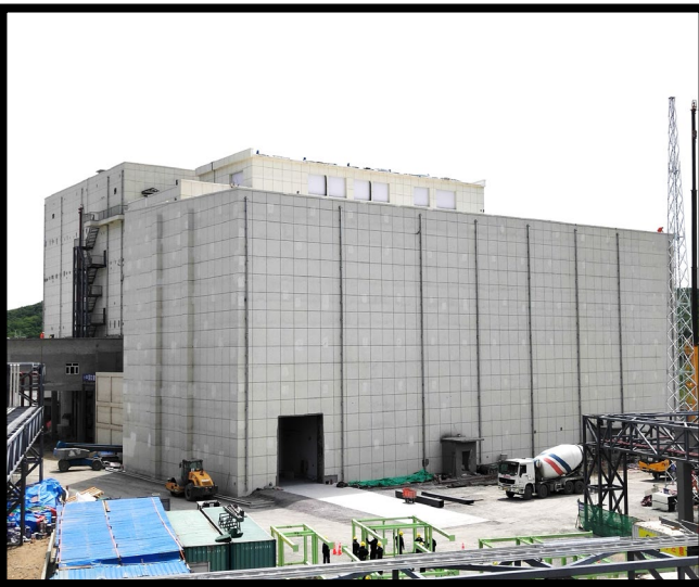
大型廃棄処理設備棟
