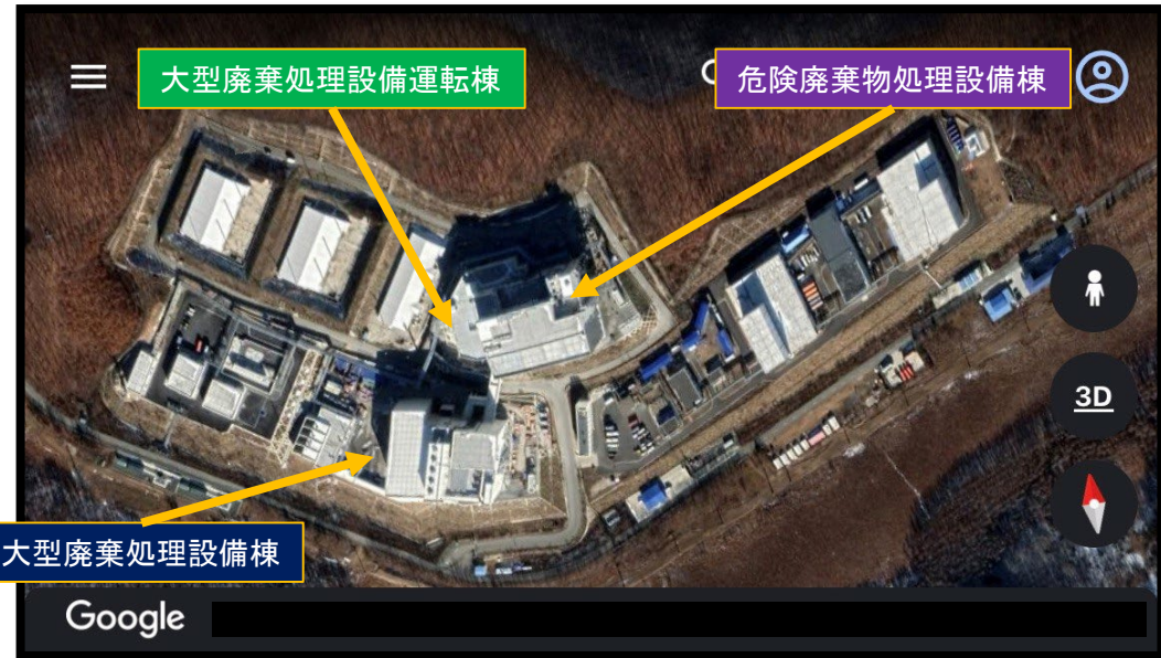
【大型廃棄処理設備等 建屋完成写真】
